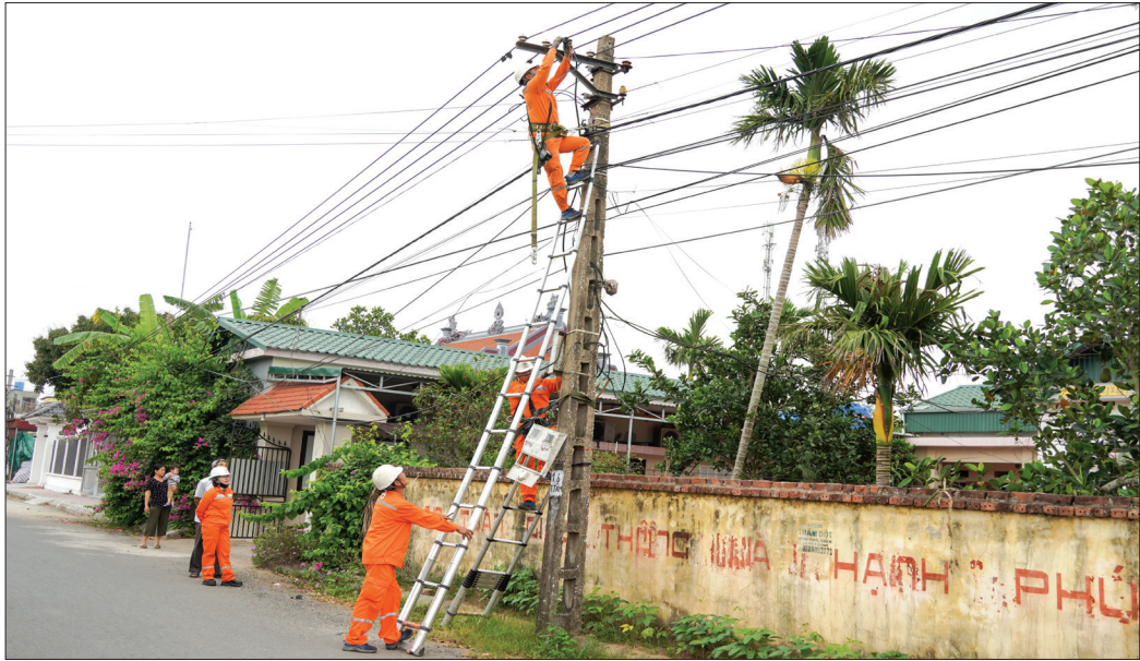
Điện lực Thái Thụy sửa chữa lưới điện, bảo đảm vận hành an toàn, ổn định.
