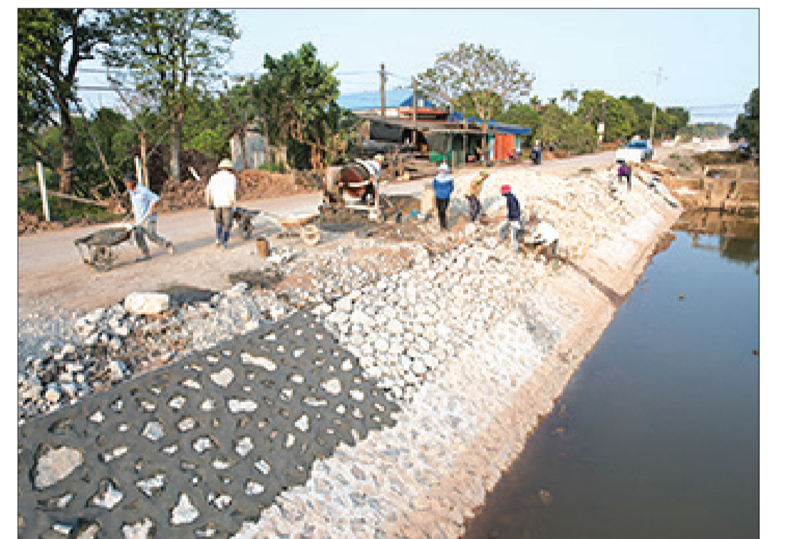
Thi công dự án cải tạo, nâng cấp tuyến đường từ chùa Keo đi Cổ Lễ.
