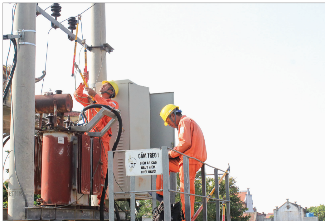
Công nhân Điện lực Tiên Hải kiểm tra trạm biến áp bảo đảm cấp điện an toàn, ổn định.
