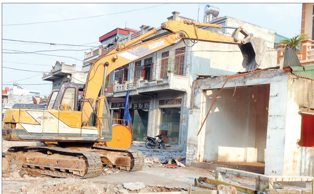
Người dân xã Vũ Phúc (thành phố Thái Bình) tháo dỡ các công trình nhà ở góp phần đẩy nhanh tiến độ thi công công trình.
