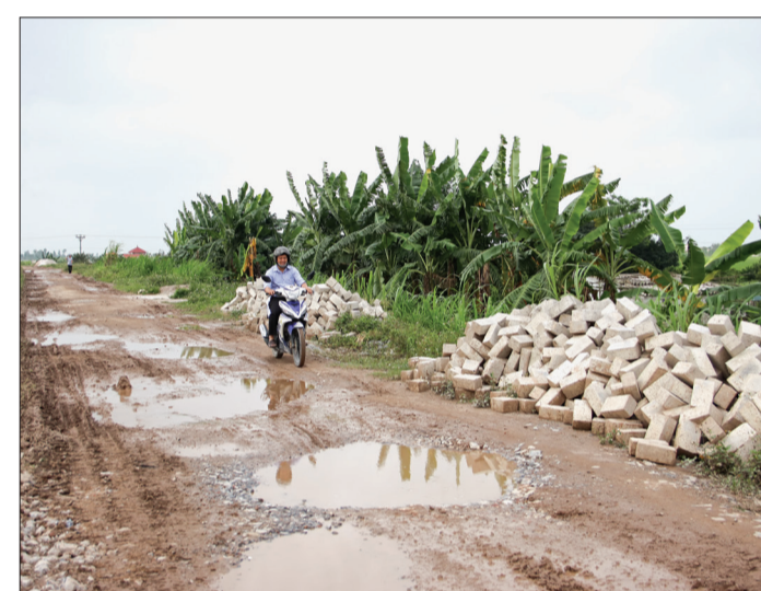
Một số tuyến đê tại huyện Quỳnh Phụ đang bị xuống cấp do xe chở vật liệu xây dựng quá tải gây ra.
