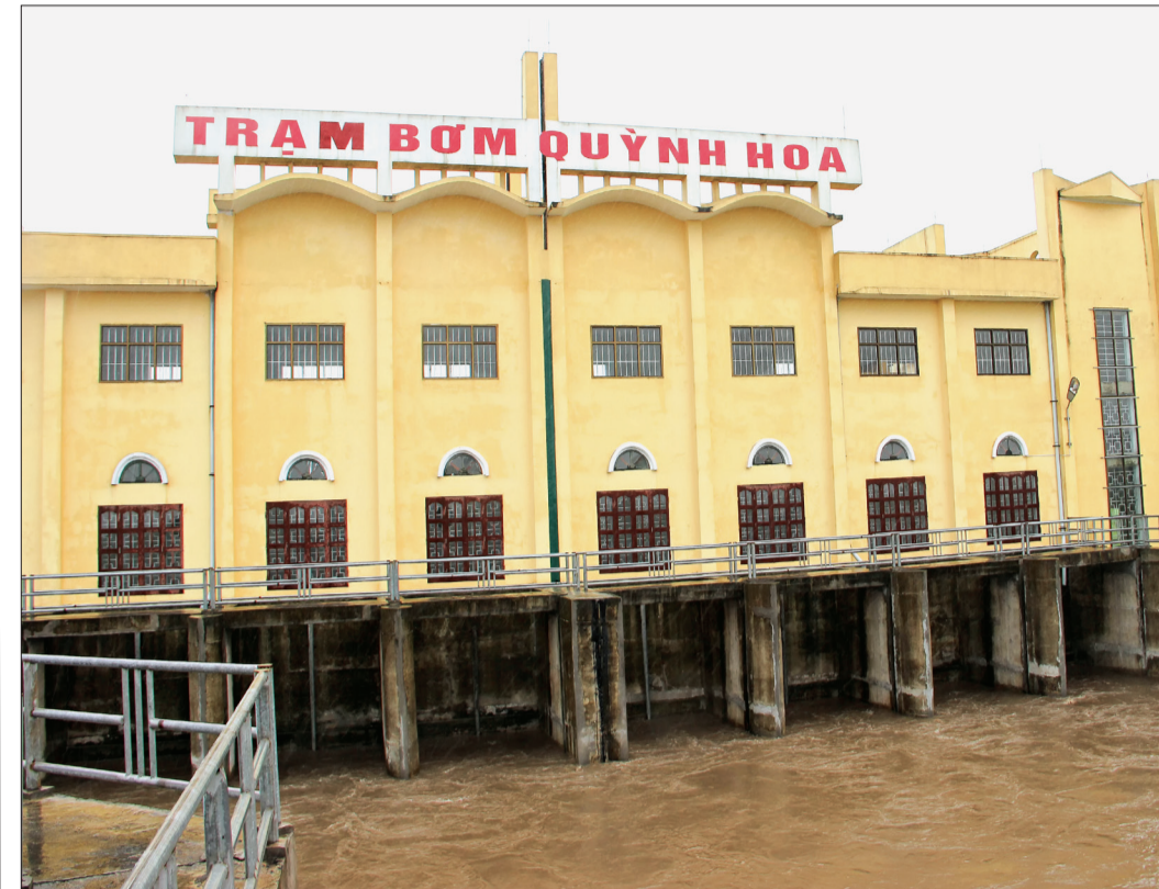
Trạm bơm Quỳnh Hoa, xã Quỳnh Hoa (Quỳnh Phụ).
