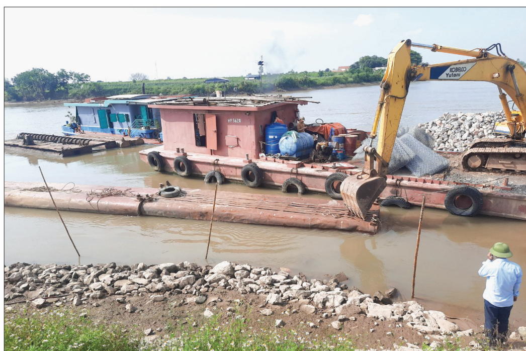
Các đơn vị chuẩn bị thi công kè Hoà Nam, xã Liên Hoa.
