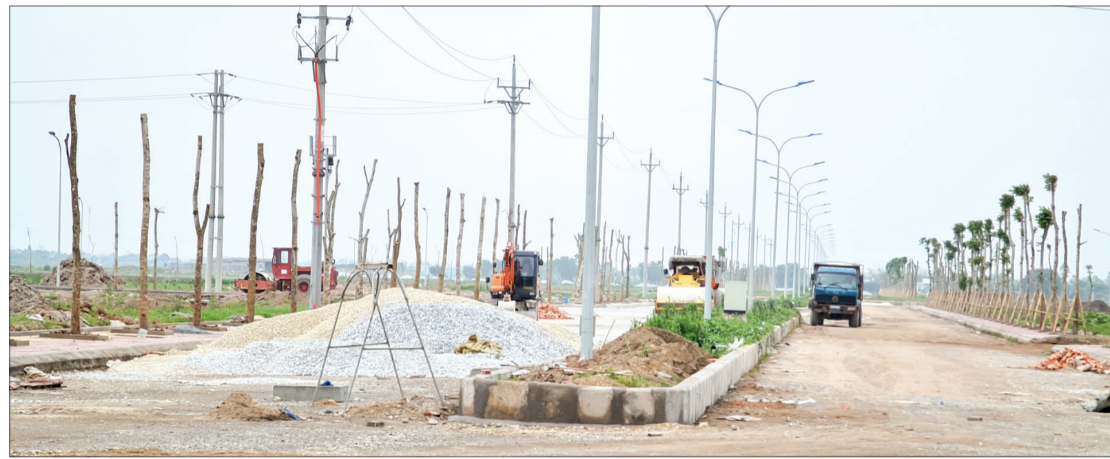
Cụm công nghiệp An Ninh (Tiền Hải) đang được đầu tư xây dựng hạ tầng.
