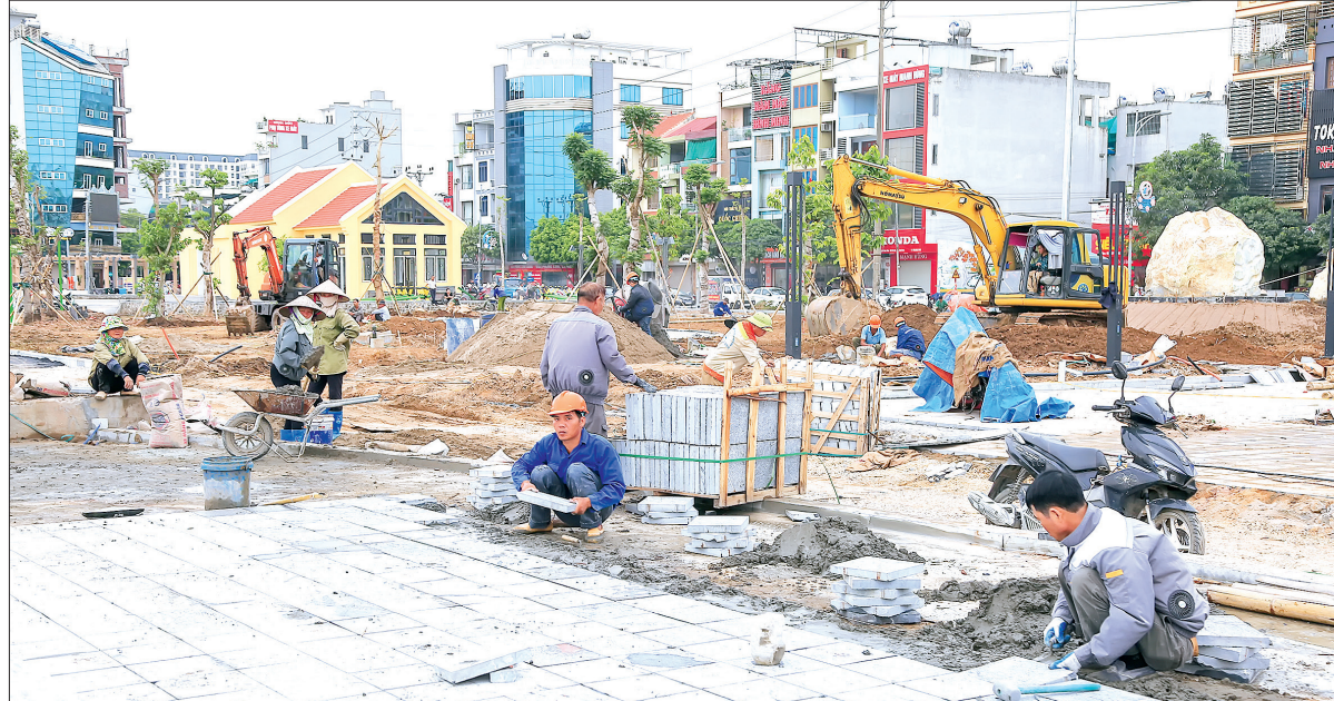
Công nhân khẩn trương hoàn thiện các hạng mục còn lại tại công viên Kỳ Bá.
