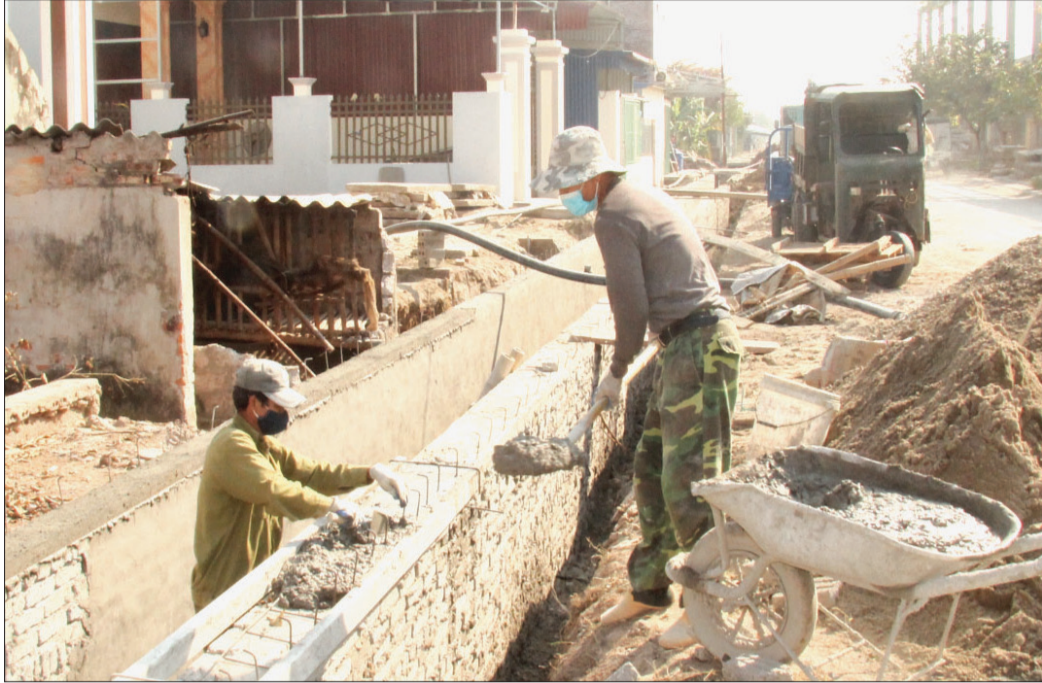
Thi công tuyến đường ĐH.65A đoạn qua xã Cộng Hòa (Hưng Hà).
