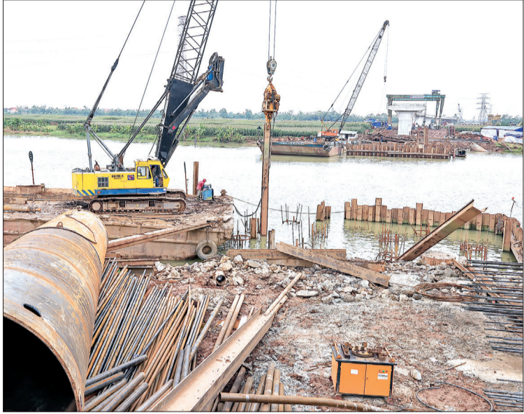
Cầu La Tiến đang được các nhà thầu tập trung thi công.
