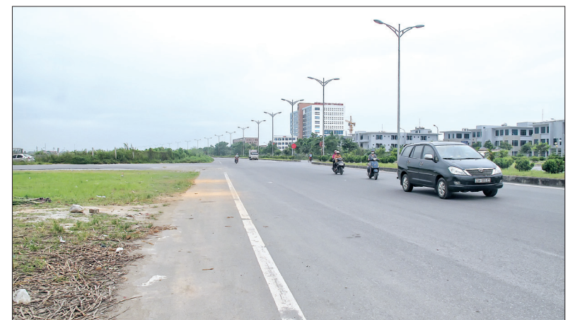
Lòng đường vành đai phía Nam, đoạn gần khu nhà ở liền kề cán bộ Bộ Chỉ huy Bộ đội Biên phòng Thái Bình không còn tình trạng ô tô nổi thành hàng dài, tỏa sức buồn bán.
