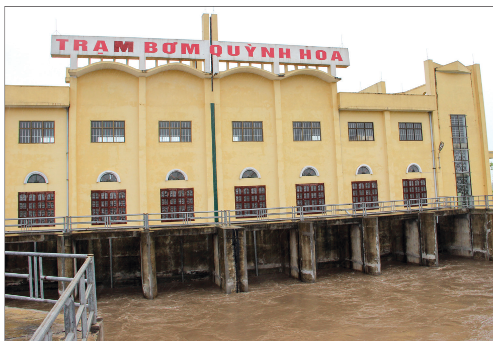
Trạm bơm Quỳnh Hoa (Quỳnh Phụ) sẵn sàng phục vụ trong mùa mưa bão.
