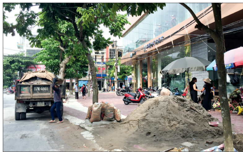
Vật liệu xây dựng lấn chiếm vỉa hè trước cổng Ban Bảo vệ, chăm sóc sức khỏe cán bộ tỉnh.
