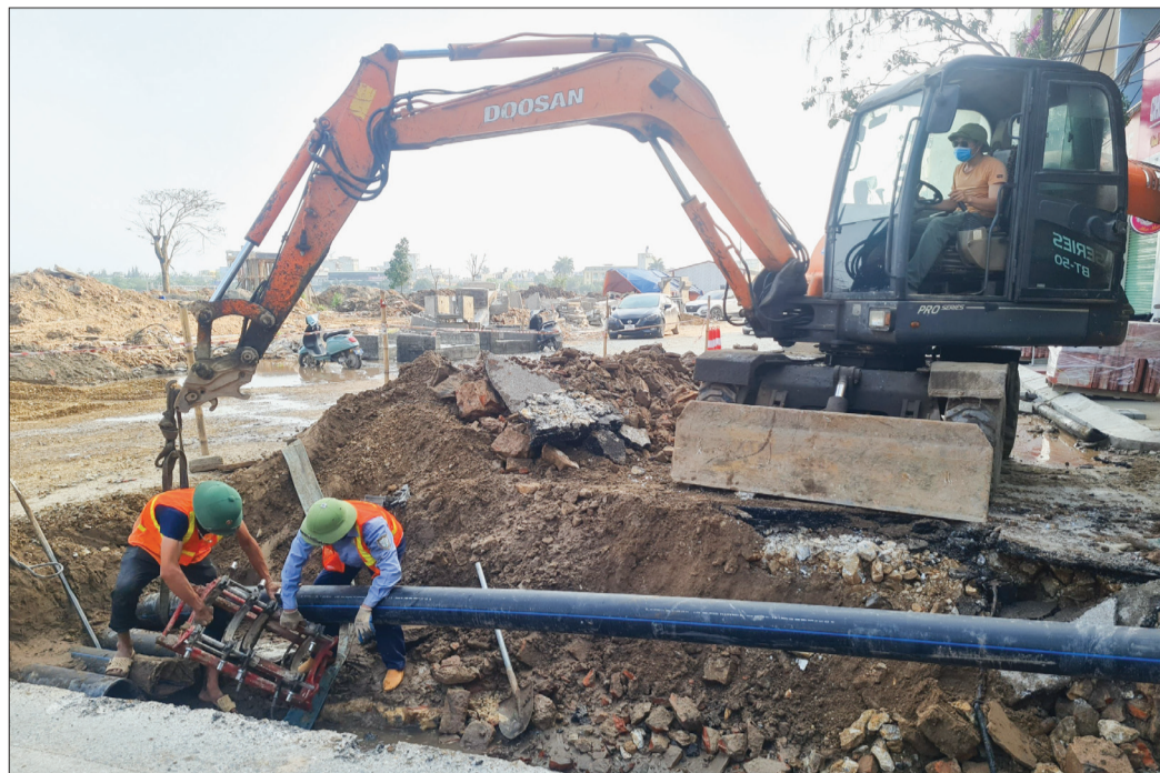
Thi công hạ tầng giao thông tuyến đường Lê Đại Hành.
