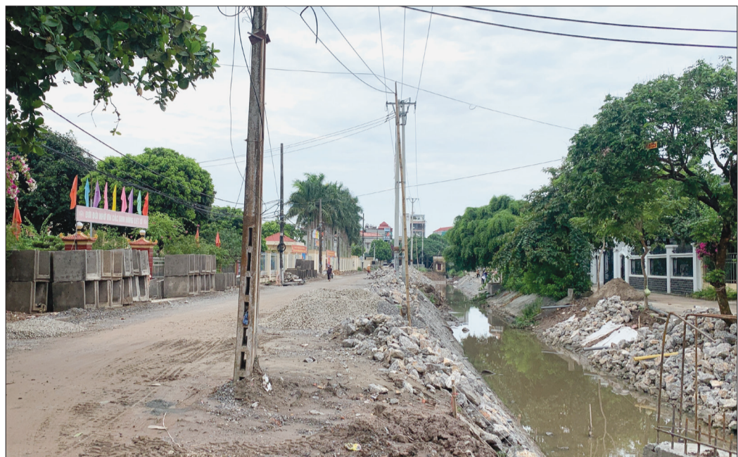
Cột điện giữa đường (ảnh chụp tại dự án đường cứu hộ, cứu nạn qua xã Tân Phong, Vũ Thư).
