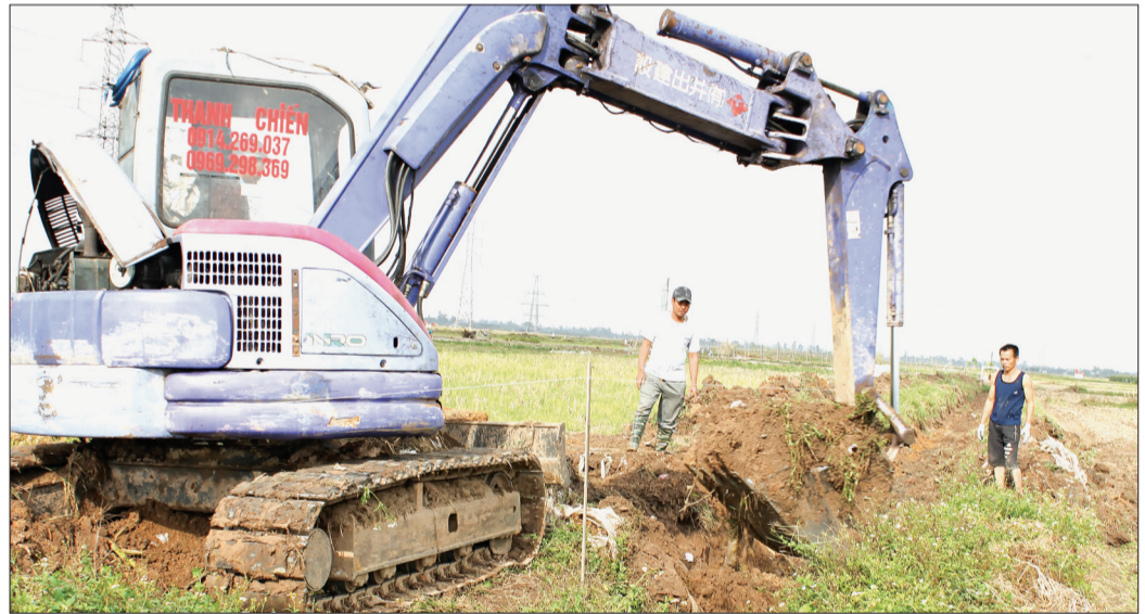
Xã Việt Hùng (Vũ Thư) huy động máy móc đảo đắp bờ vùng trên cánh đồng thôn Mỹ Lộc 2.
