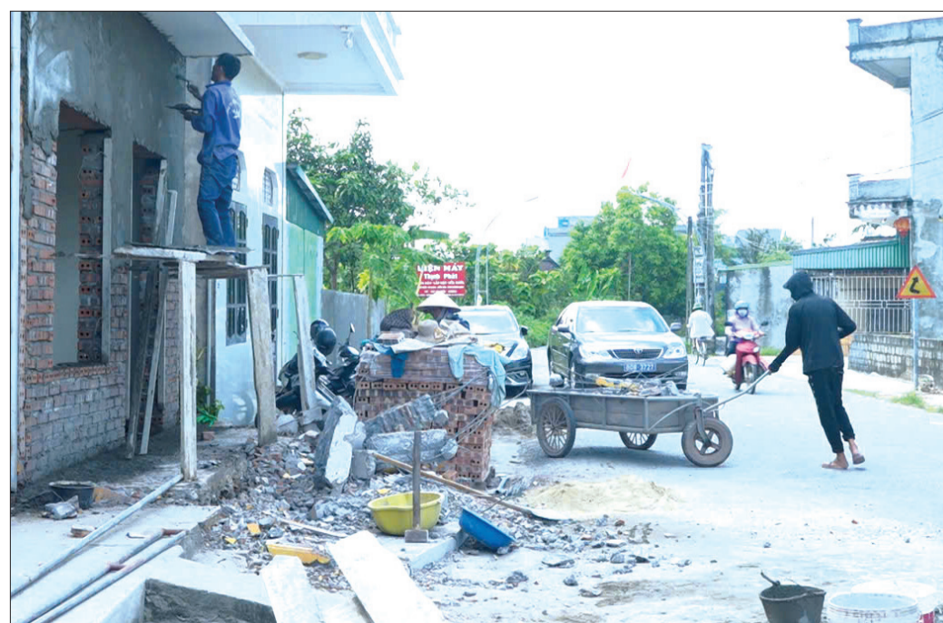
Người dân xã Đông Cơ (Tiền Hải) hiến đất và tháo dỡ công trình để mở rộng đường ĐH.36.
