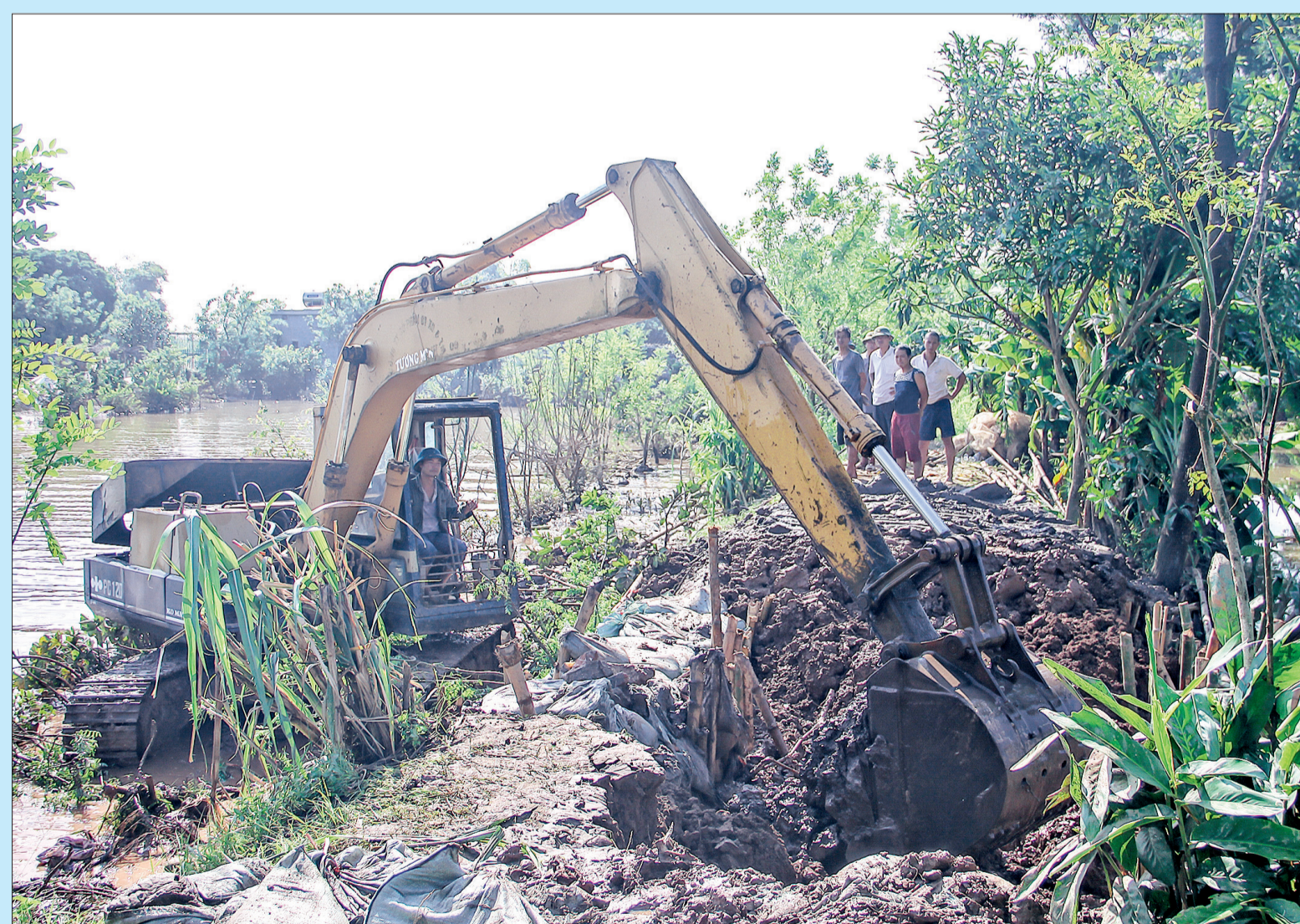
Xã Vũ Hòa (Kiến Xương) huy động máy móc, nhân lực cắm cọc, xử lý khẩn cấp các điểm xung yếu tuyến bờ bao khu vực nuôi trồng thủy sản.
