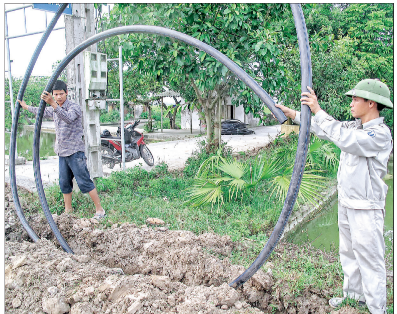
Công ty Cổ phần Nước sạch Hưng Hà triển khai lắp đặt đường ống nước trong phạm vi vùng dự án. Ảnh: MAI TRANG
