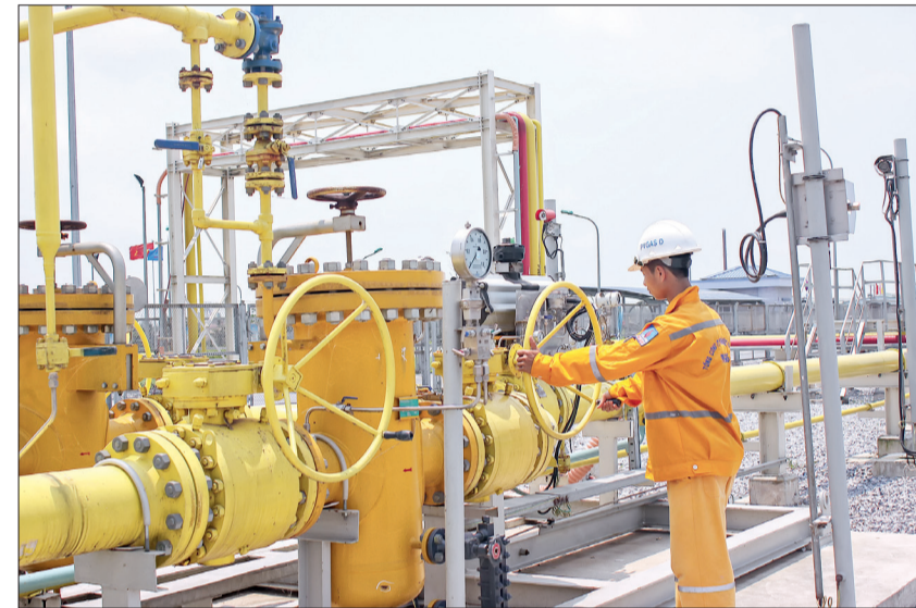
Hệ thống dẫn khí của Xí nghiệp phân phối khí thấp áp miền Bắc.
