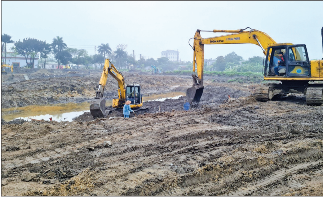
Thi công công trình xây dựng và lắp đặt thiết bị công trình hồ Ty Diệu.
