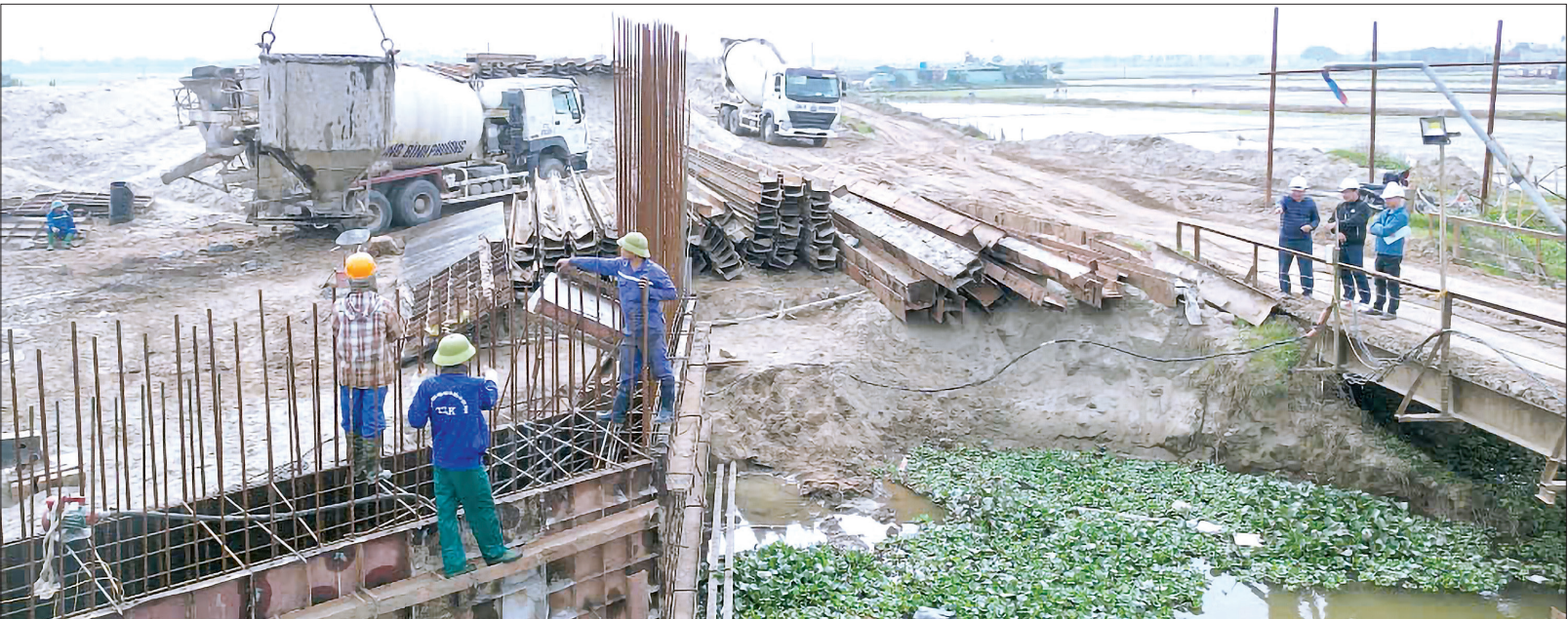
Thi công tuyến đường số 3, đường trục Khu kinh tế Thái Bình.
