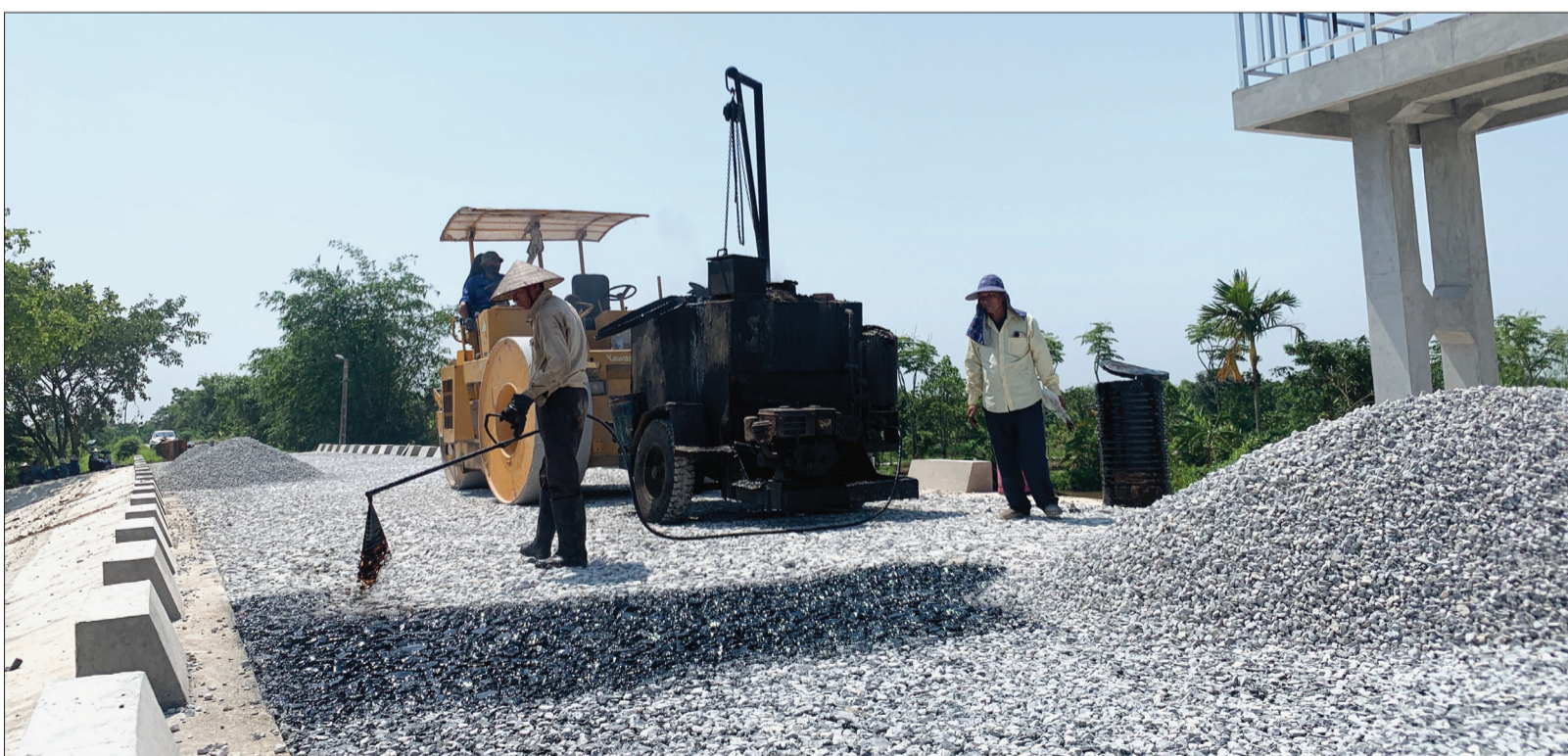
Đơn vị thi công đang hoàn thiện láng nhựa mặt đường, công trình xử lý cấp bách công xã qua đê tại Km192+270 đê tả Hồng Hà II, thuộc địa phận xã Minh Tân (Kiến Xương).
