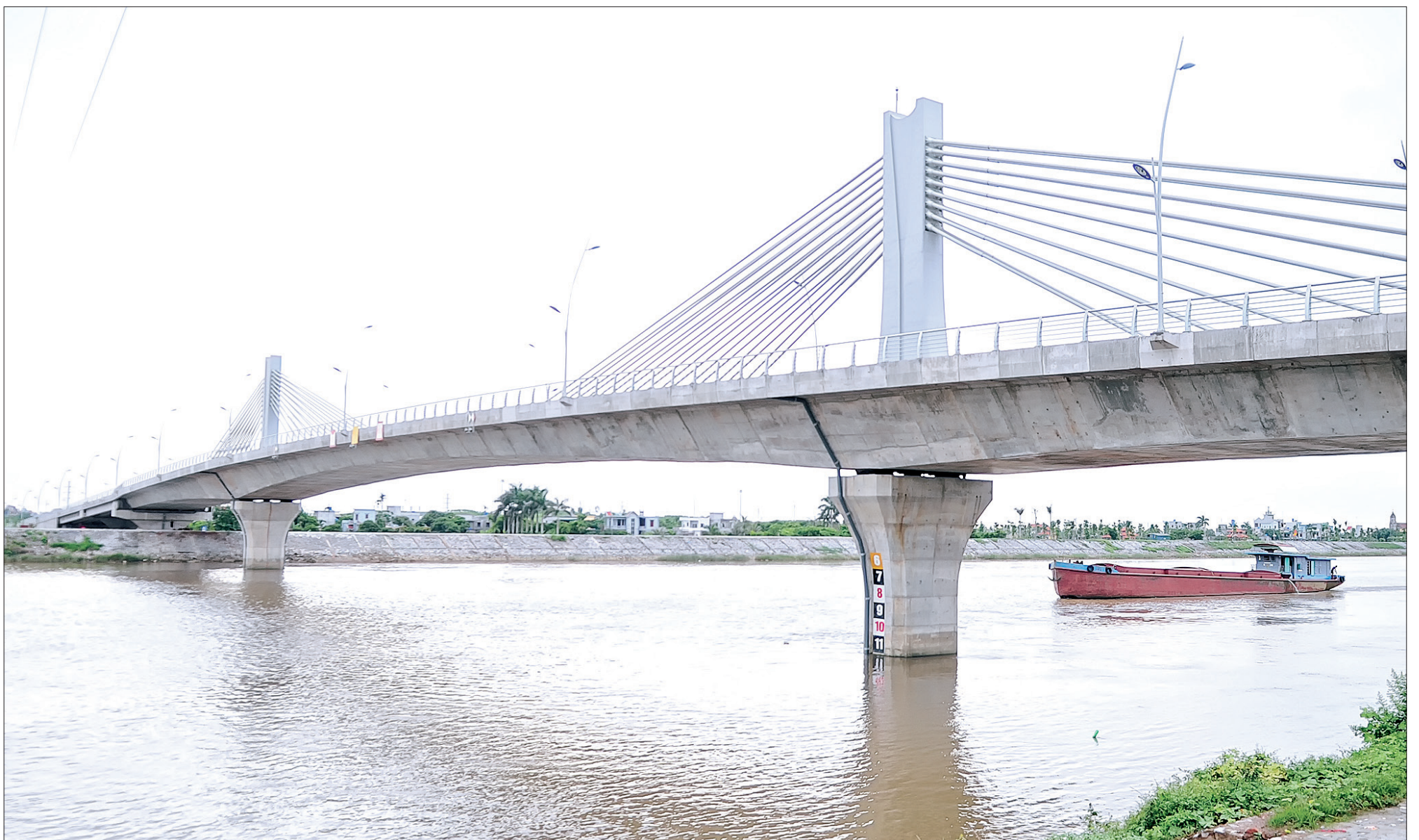
Cầu vượt sông Trà Lý.
