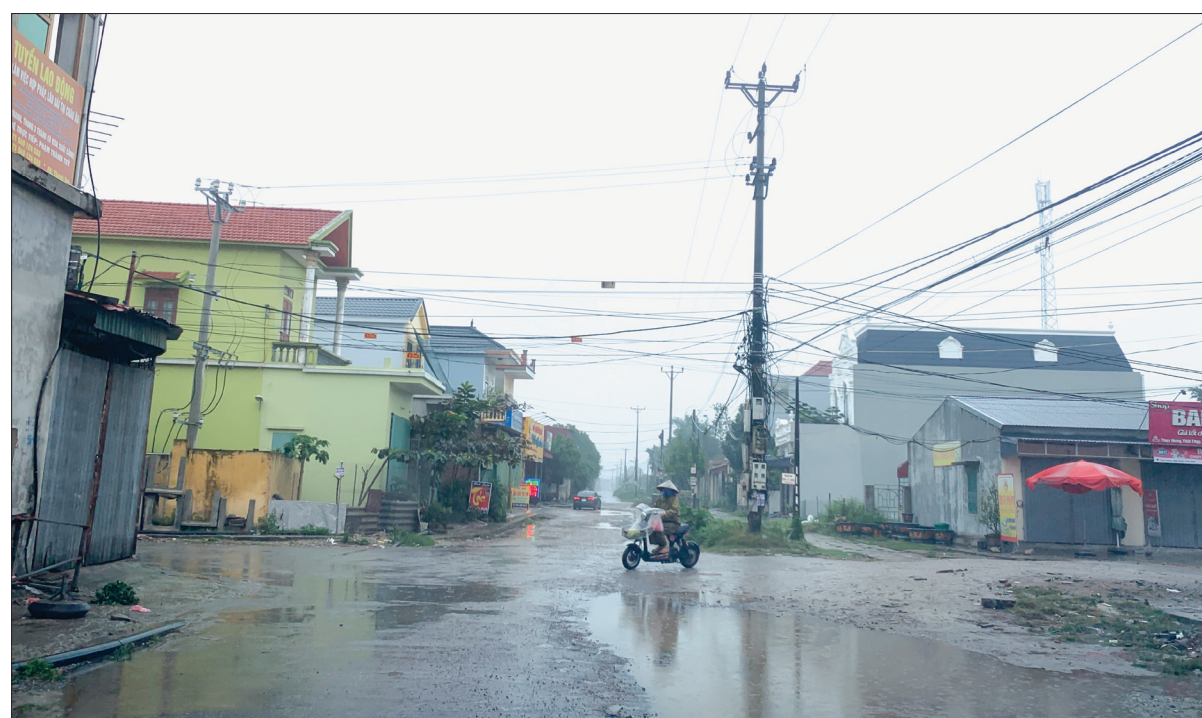
Tuyến đường ĐH.95B giai đoạn 2 từ Thụy Phúc đi Thụy Hưng (Thái Thụy) còn vướng mắc nhiều cột điện chưa dịch chuyển.
