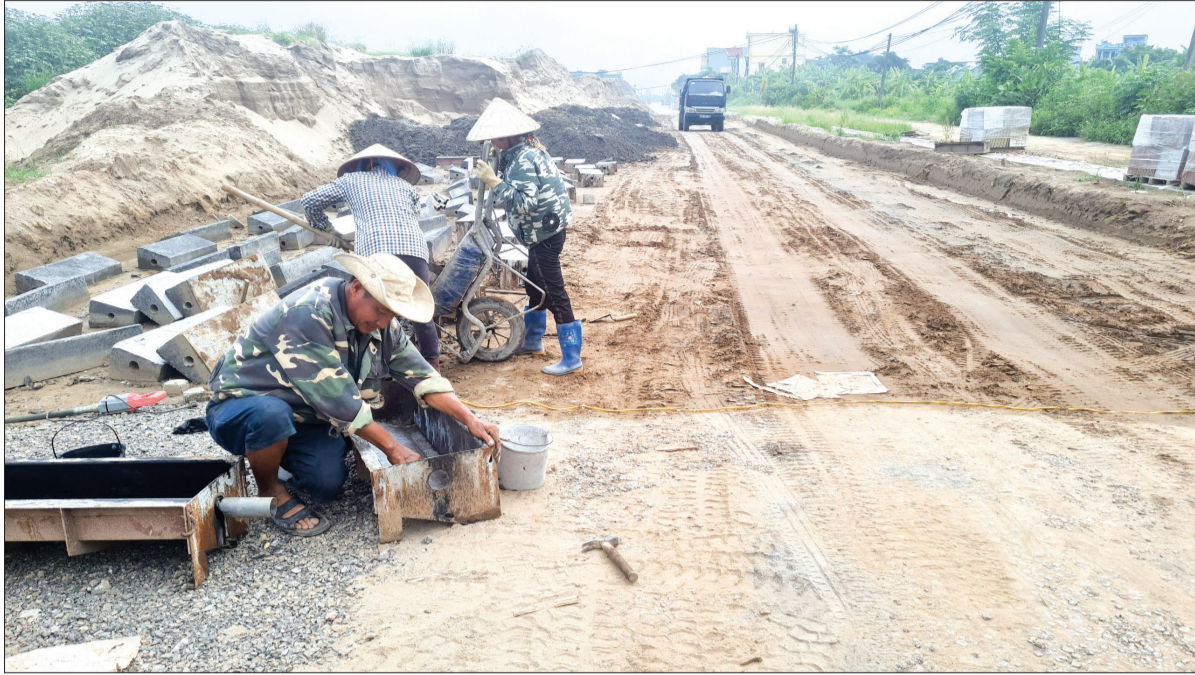
Thi công đường đến trung tâm xã Vũ Đông (đoạn từ đường Trần Lãm qua thôn Tam Lạc, xã Vũ Lạc đến xã Vũ Đông).
