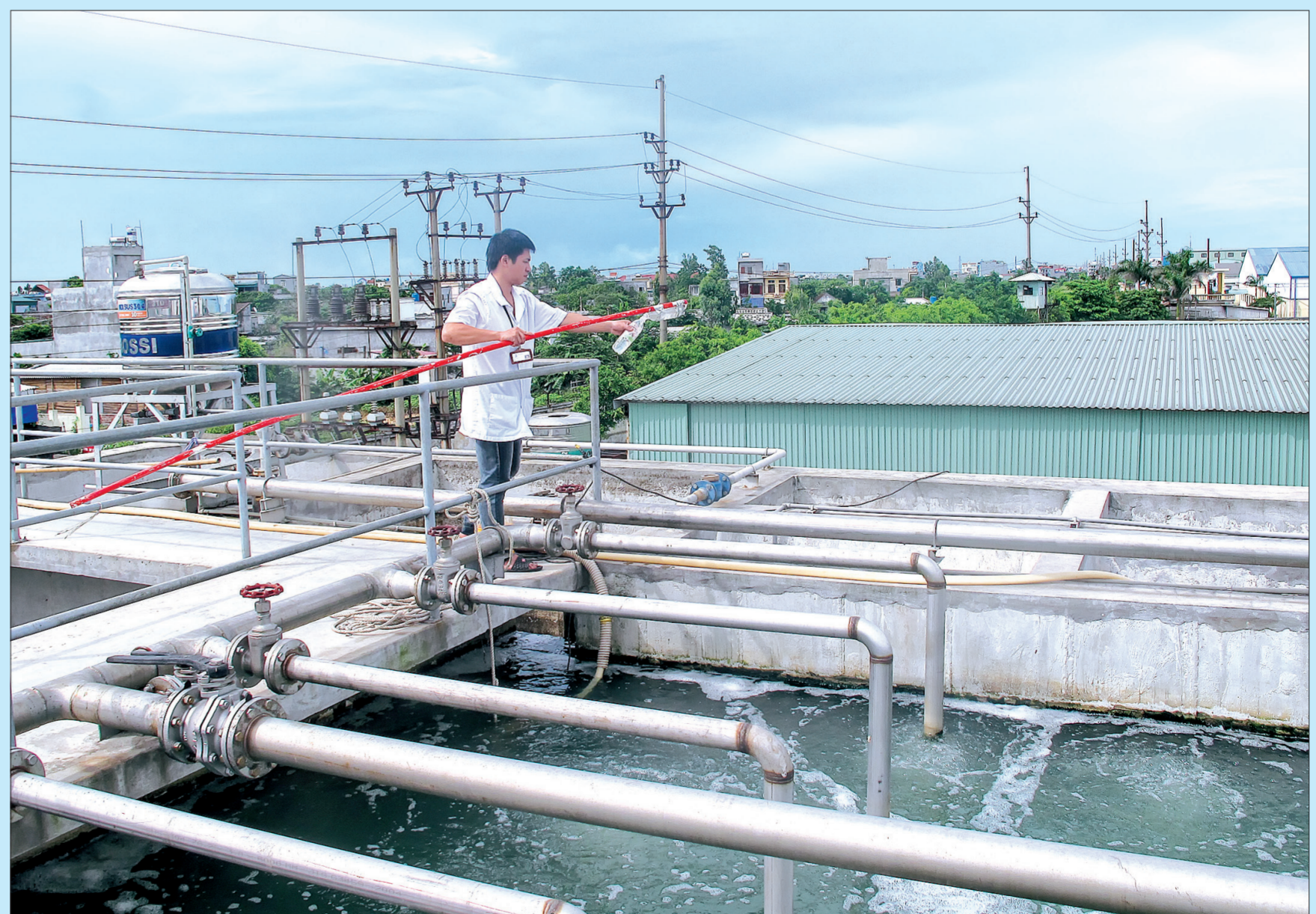
Lấy mẫu kiểm tra chất lượng nước thải tại Công ty TNHH May TAV (khu công nghiệp Nguyễn Đức Cảnh).
