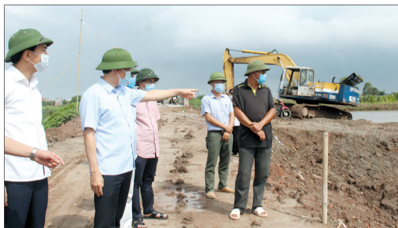
Đồng chí Lai Văn Hoàn, Tỉnh ủy viên, Phó Chủ tịch UBND tỉnh kiểm tra tiến độ thi công hạng mục xây mới cống Láng Quai tại K4+100, đê cửa sông tá Diêm Hộ (Thái Thụy).
