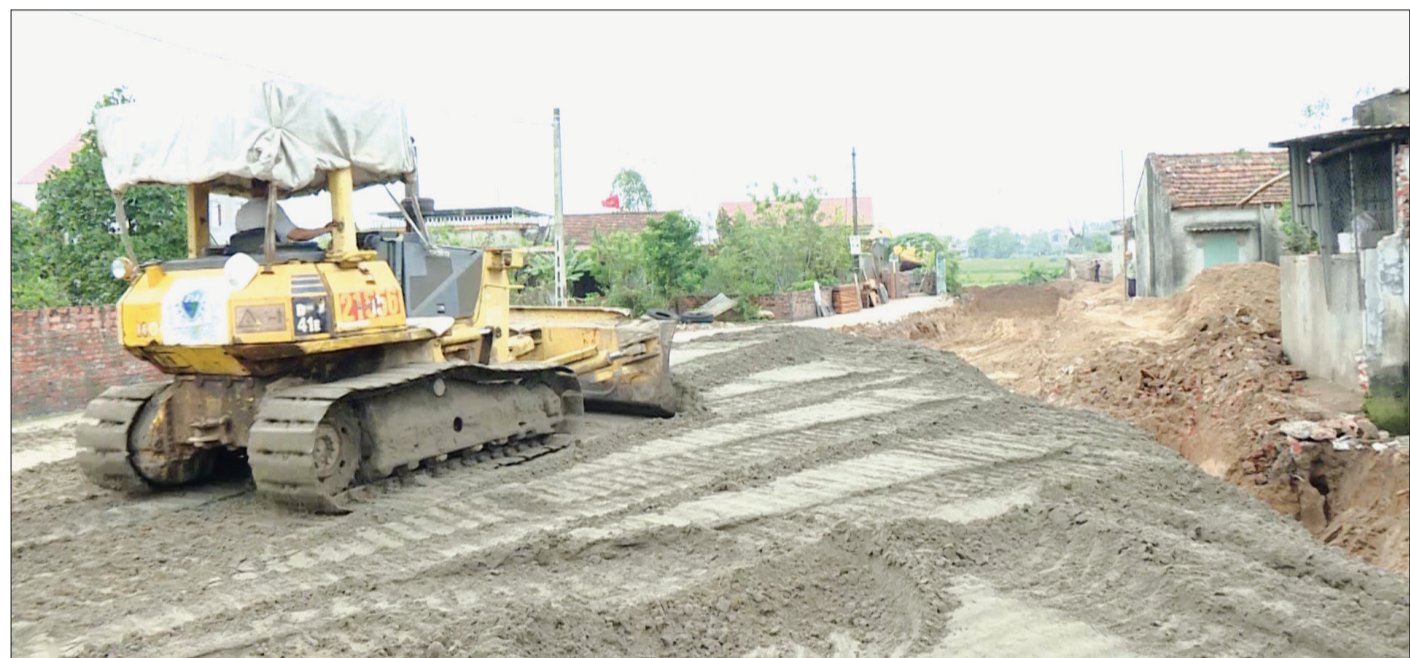
Thi công tuyến đường bộ ven biển đoạn qua xã Thái Thượng (Thái Thụy).
