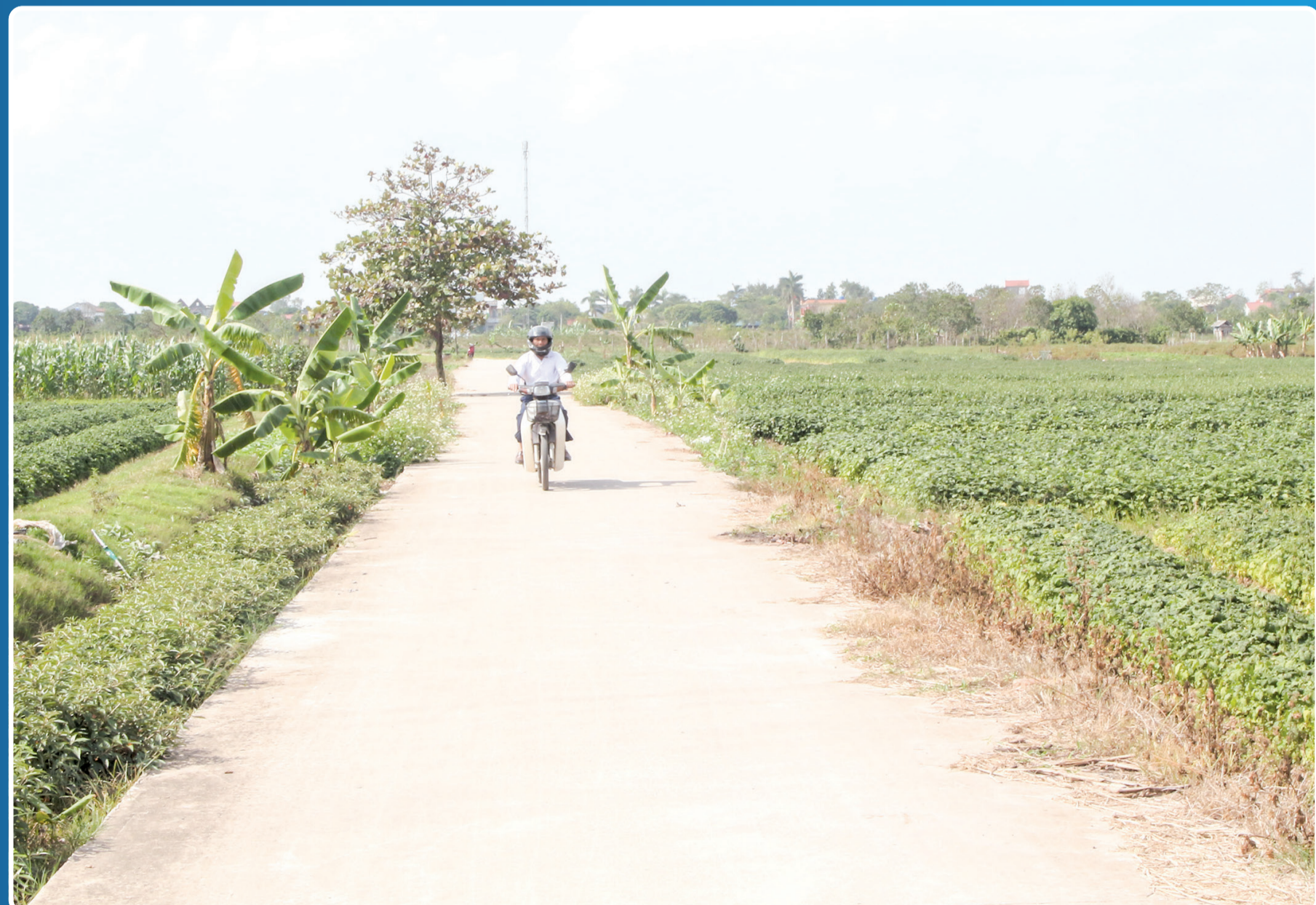
Tuyến đường nội đồng thôn An Mai, xã Thống Nhất được huyện Hưng Hà đầu tư xây dựng sau khi có ý kiến, kiến nghị của cử tri.
