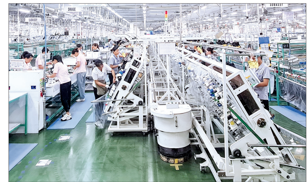
Hệ thống chiếu sáng trong xưởng sản xuất của Công ty TNHH Yazaki Hải Phòng Việt Nam chi nhánh Thái Bình sử dụng bóng đèn led.
