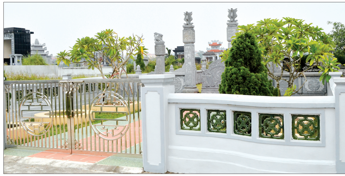
Khuôn viên lăng mộ tại nghĩa trang xã Phú Châu (Đông Hưng) được xây dựng khang trang, có tường bao, cổng đậu.
