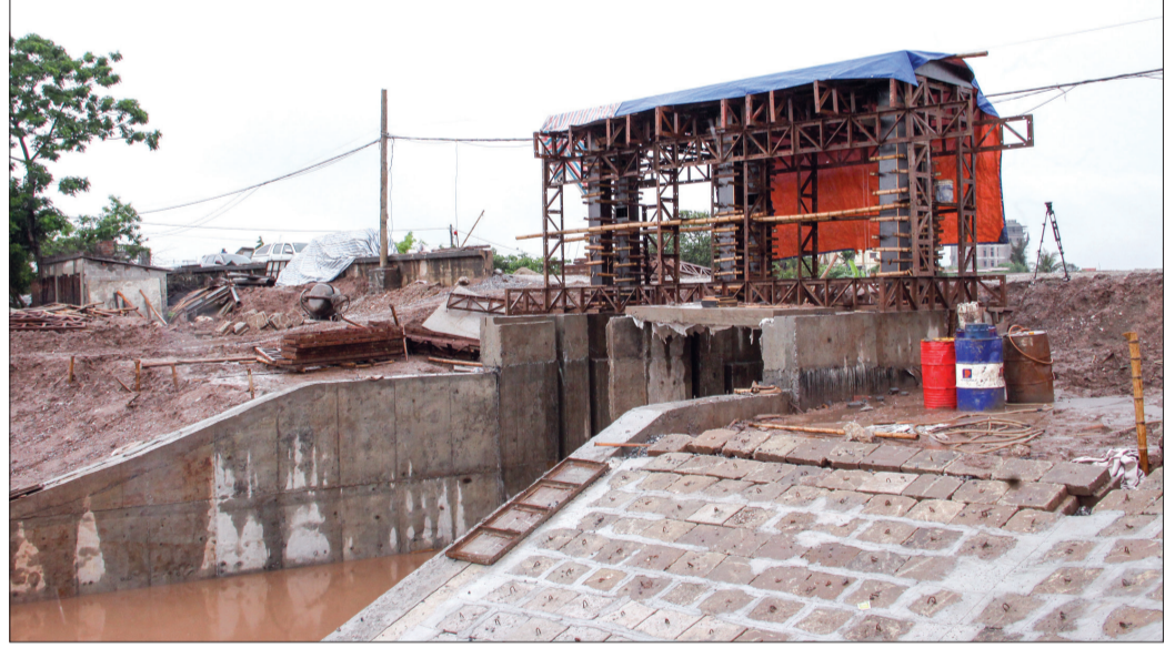
Công trình xây dựng, cải tạo cống Khổng, xã Nam Hưng (Tiền Hải) phần đầu hoàn thành cuối tháng 5/2018.
