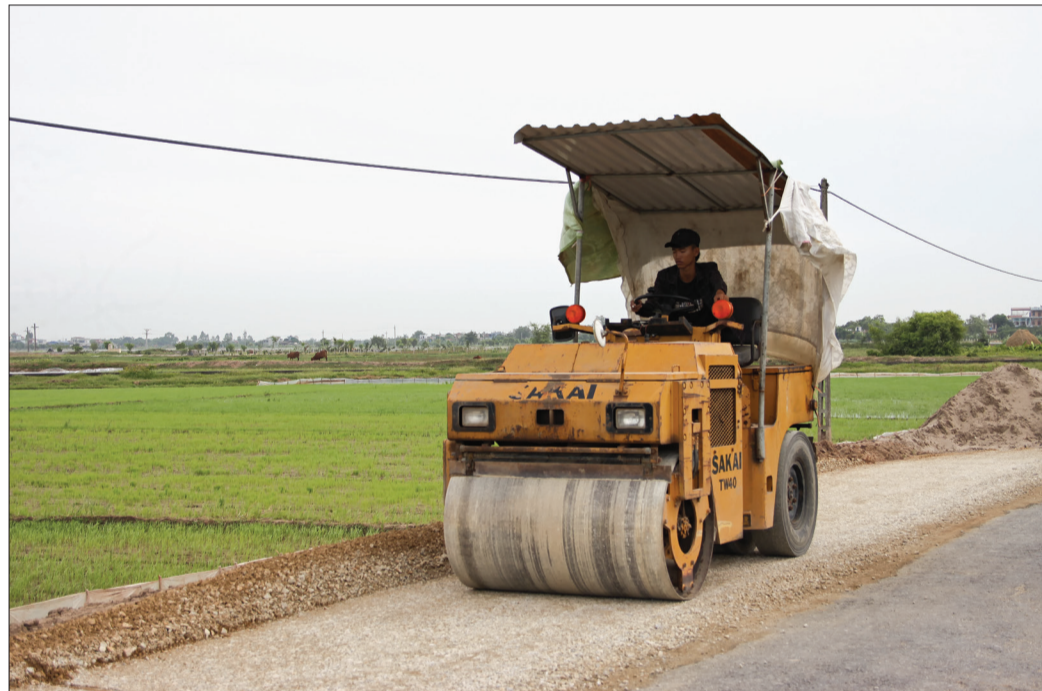
Thi công đường ĐH.01 (đường 220A) đoạn còn lại từ dốc Búng, xã Việt Hùng đến bến Rống, xã Hiệp Hòa (Vũ Thư).
