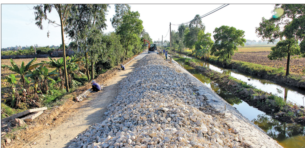
Thi công tuyến đường ĐH12 qua địa bàn xã Tự Tân.
