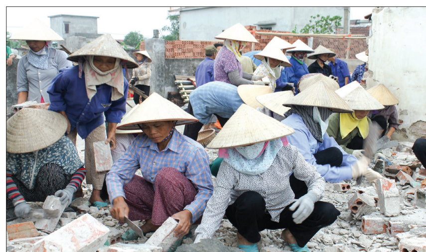
Nhân dân xã Tự Tân ủng hộ ngày công xây dựng nhà ở cho gia đình hoàn cảnh khó khăn trên địa bàn.
