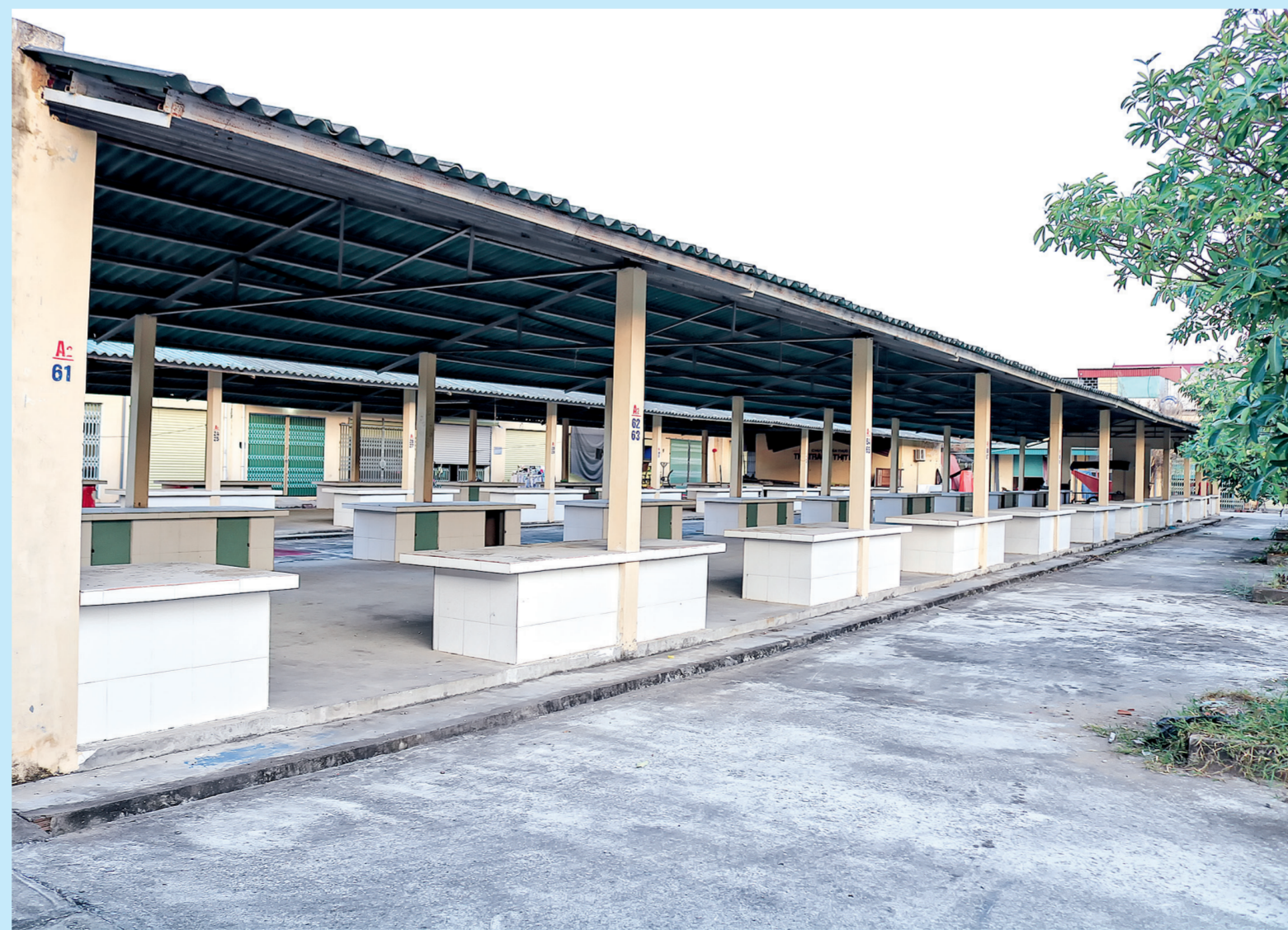
Chợ Quỳnh Côi mới hoàn thành xây dựng từ năm 2013 nhưng không có người họp.
