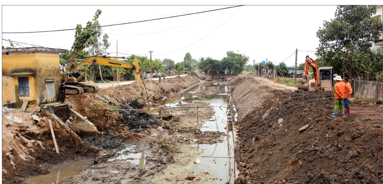
Thi công nạo vét, làm kè bờ sông N2, đoạn qua xã Thụy Quỳnh (Thái Thụy).
