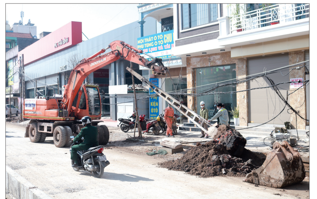
Đơn vị thi công di chuyển cột điện cũ.
