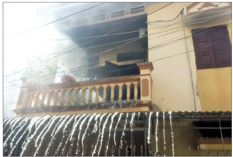
Ngôi nhà xây ra hỏa hoạn tại phường Bồ Xuyên (thành phố Thái Bình).
