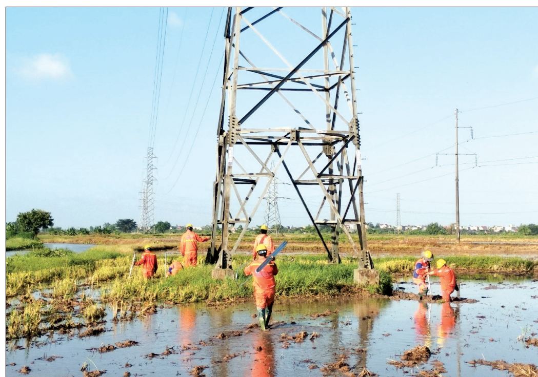
Thi công bổ sung tiếp địa đường dây 110kV.
