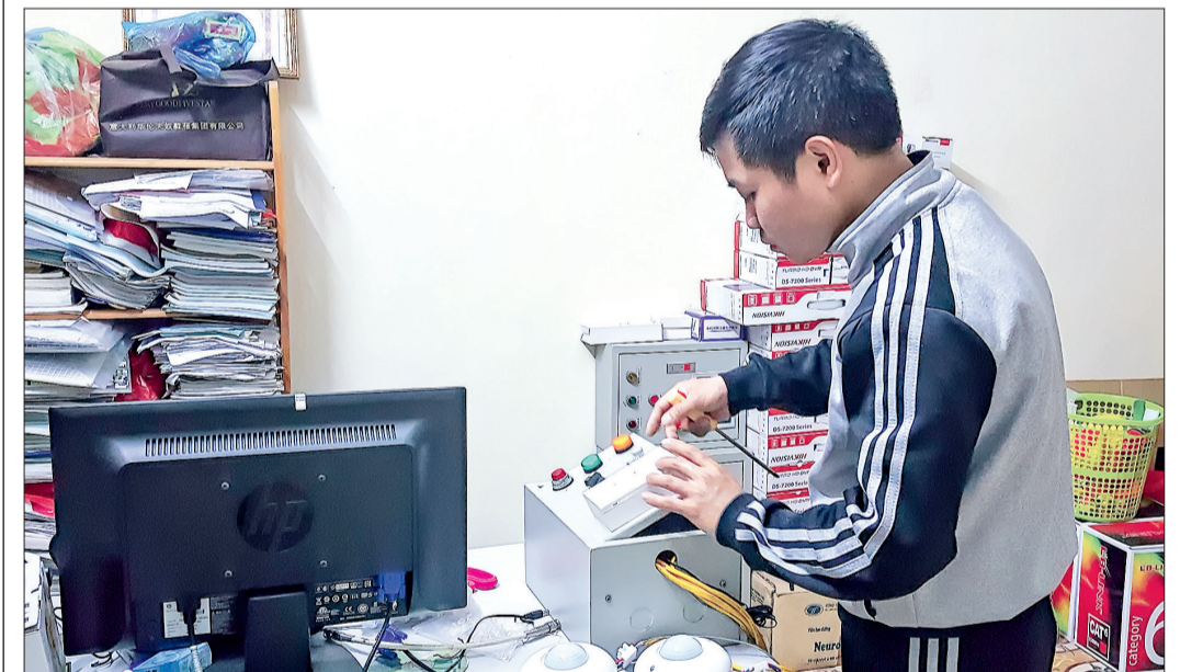
Thạc sĩ Vũ Quang Hòa lắp ráp các bộ phận của tủ điện.
