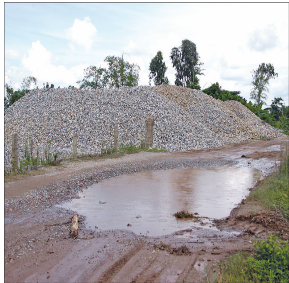
Bãi tập kết vật liệu xây dựng nằm trong hành lang bảo vệ đê.
