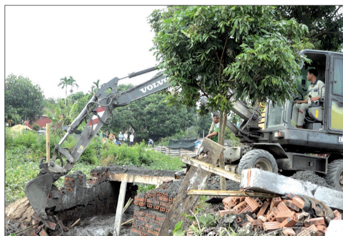
Tháo dỡ công trình xây dựng lấn chiếm dòng chảy.
