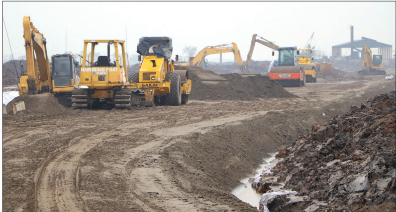
Đẩy nhanh tiến độ thi công đường vào cụm công nghiệp Ninh An (Kiến Xương).
