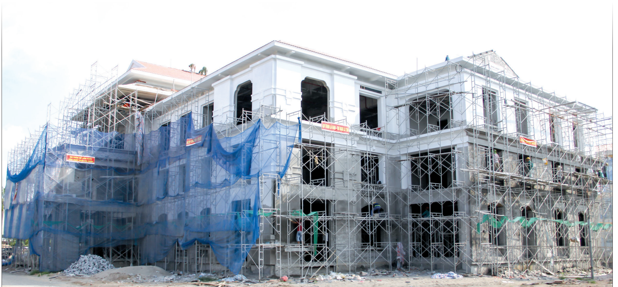
Công trình khối nhà chính và các hạng mục phụ trợ thiết yếu của Thư viện Khoa học tổng hợp tỉnh đang trong quá trình hoàn thiện.
