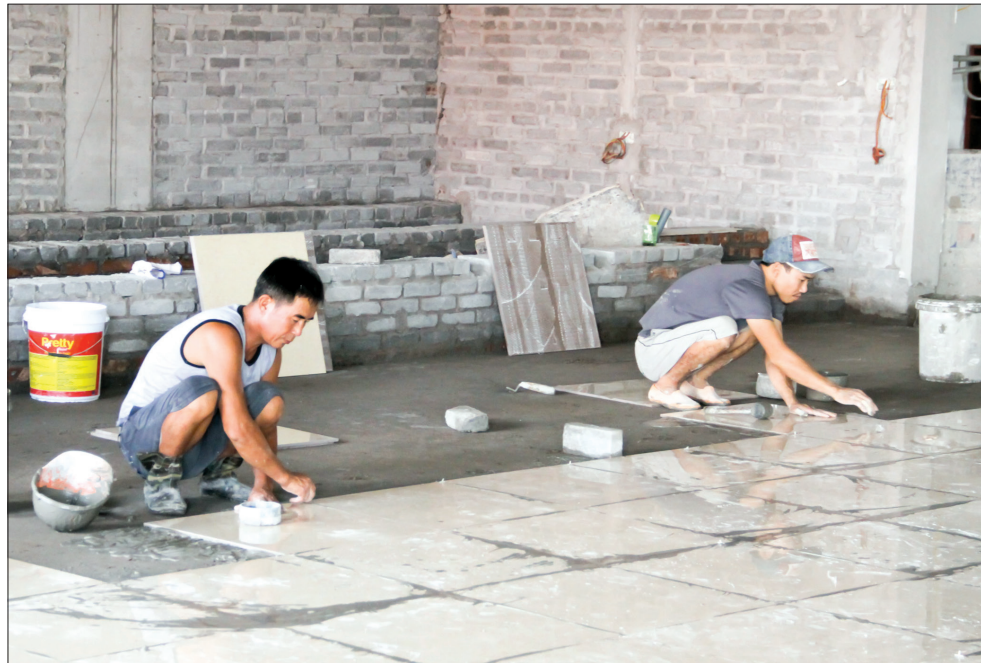
Thi công lát nền khối nhà chính.
