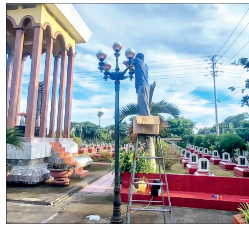
Xã Dương Hồng Thủy (Thái Thụy) tu sửa hệ thống điện tại Nghĩa trang Liệt sĩ.
