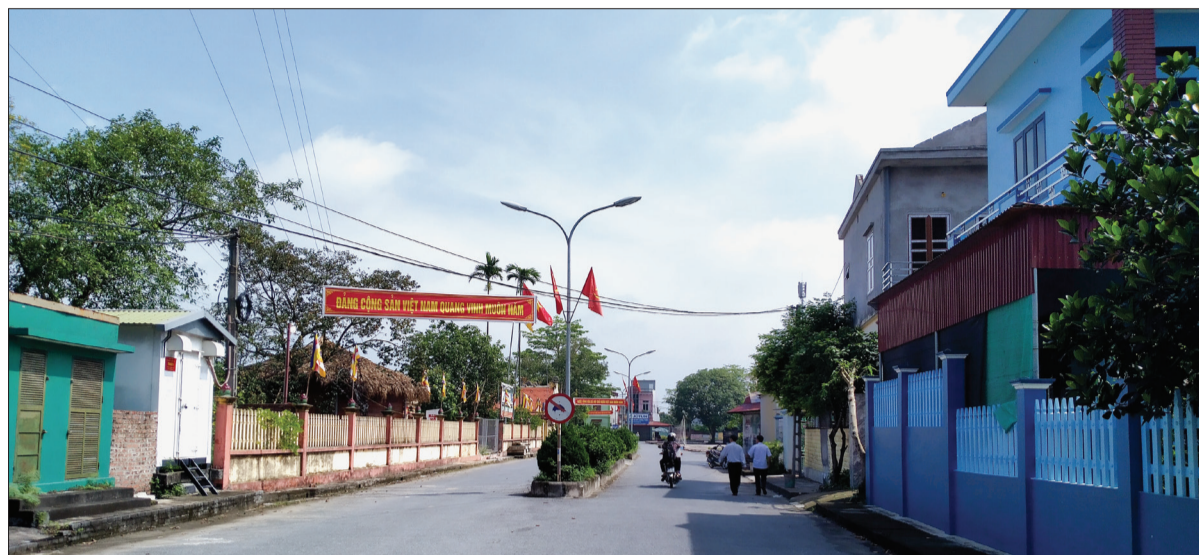
Hệ thống đường giao thông xã An Châu (Đông Hưng) được đầu tư xây dựng đồng bộ, đáp ứng nhu cầu đi lại của người dân.
