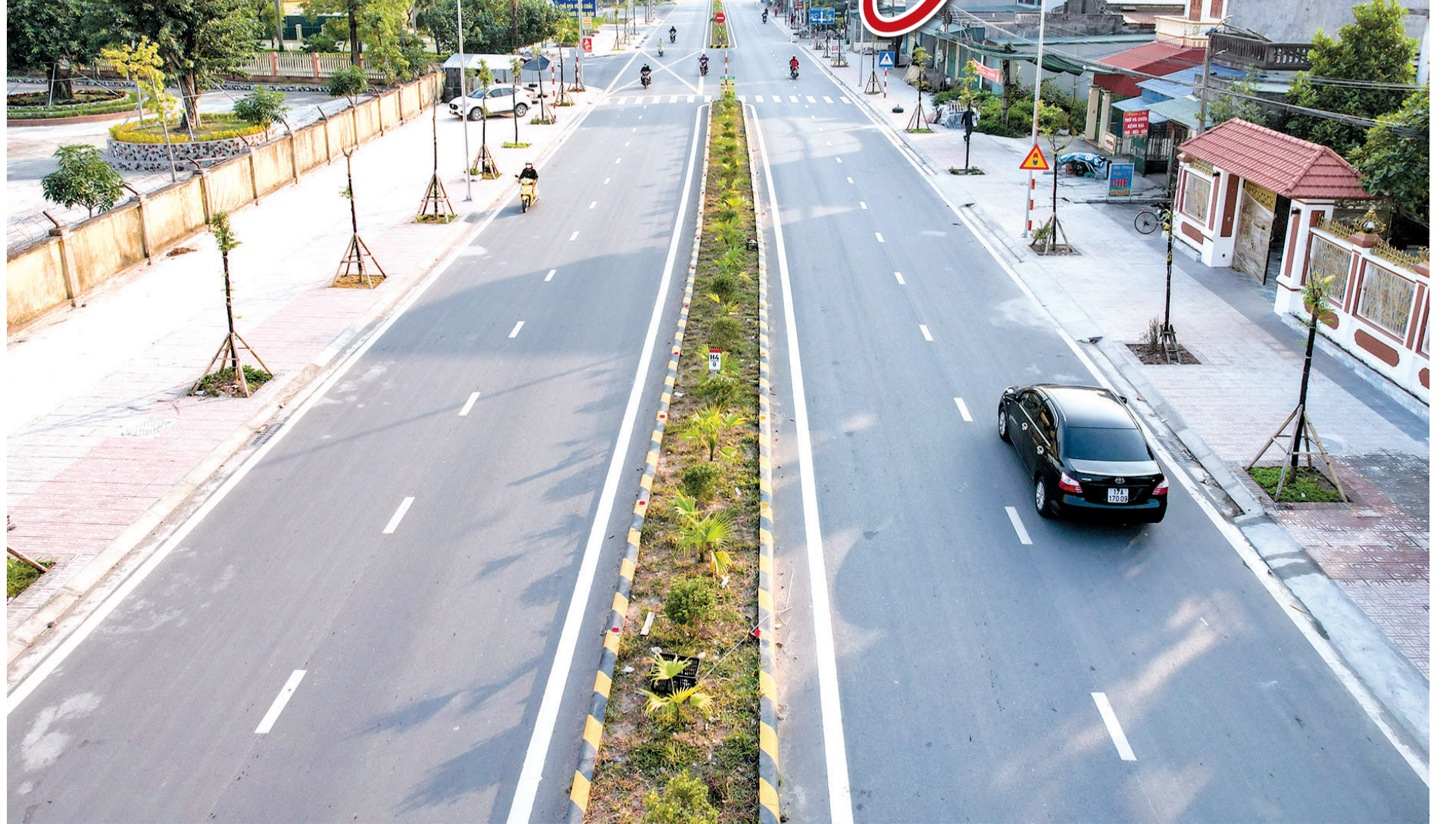
Tuyến đường 221A được hoàn thành và đưa vào sử dụng góp phần thúc đẩy phát triển kinh tế - xã hội của huyện Tiền Hải nói riêng, tỉnh Thái Bình nói chung.
