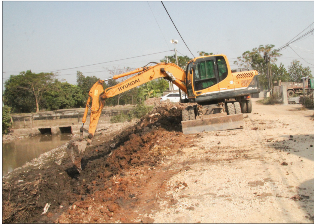
Đẩy nhanh tiến độ thi công tuyến đường ĐT.452 đoạn qua xã Dân Chủ.
