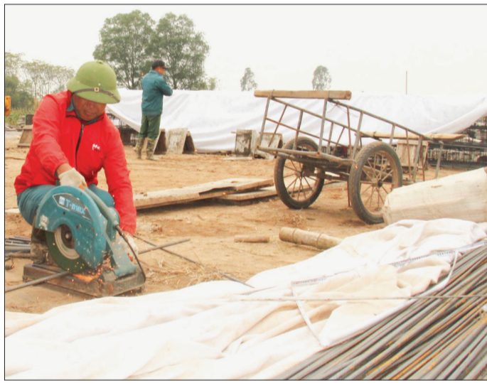
Công ty TNHH Xây dựng Đông Đô đẩy nhanh tiến độ thực hiện dự án xử lý cấp bách kè Nhâm Lang đoạn qua xã Hòa Tiến.
