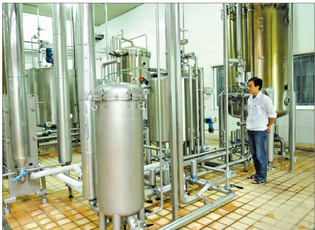
Hệ thống lọc bia và các tank lên men.
