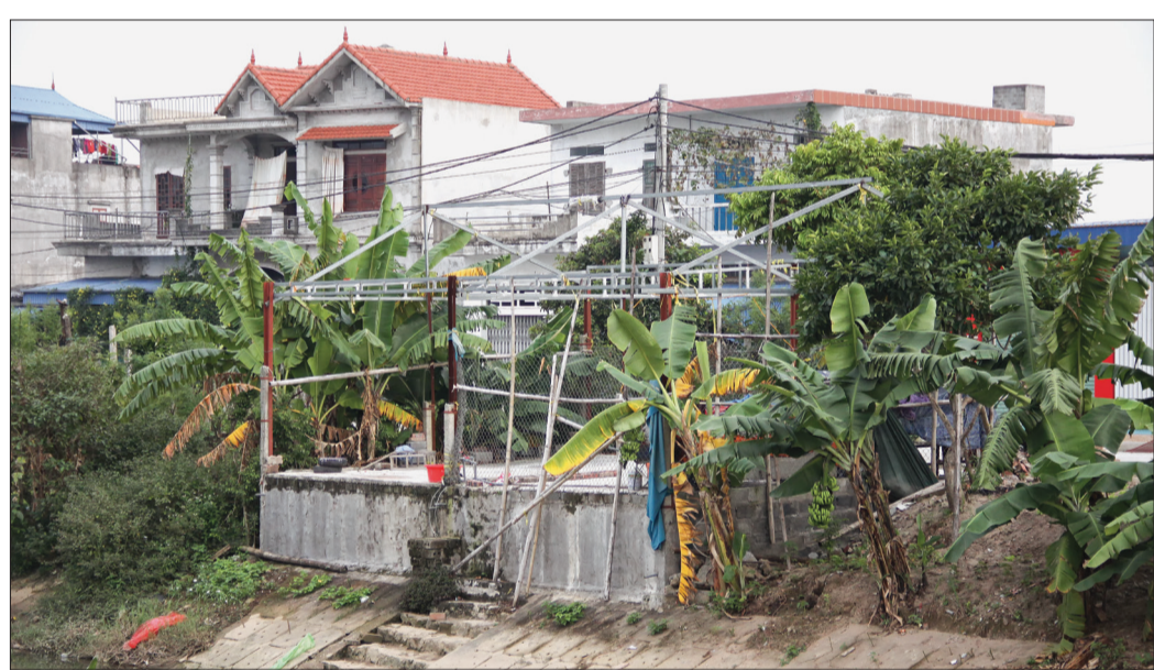
Công trình vi phạm hành lang sông Kiến Giang đoạn qua địa bàn xã Tân Lập chưa được xử lý triệt để.
