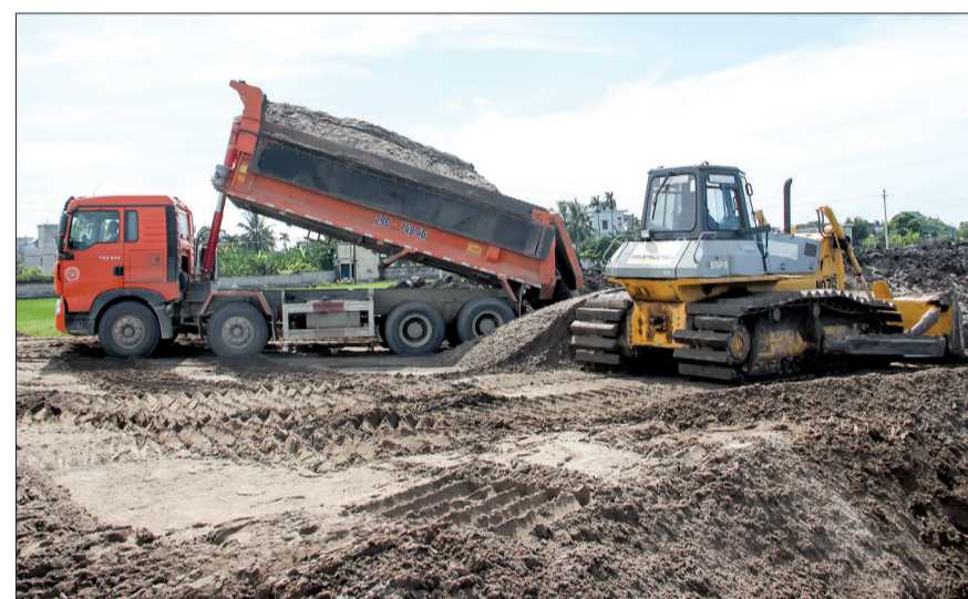
Thi công nền đường tuyến tránh thị trấn Đông Hưng (Đông Hưng).
